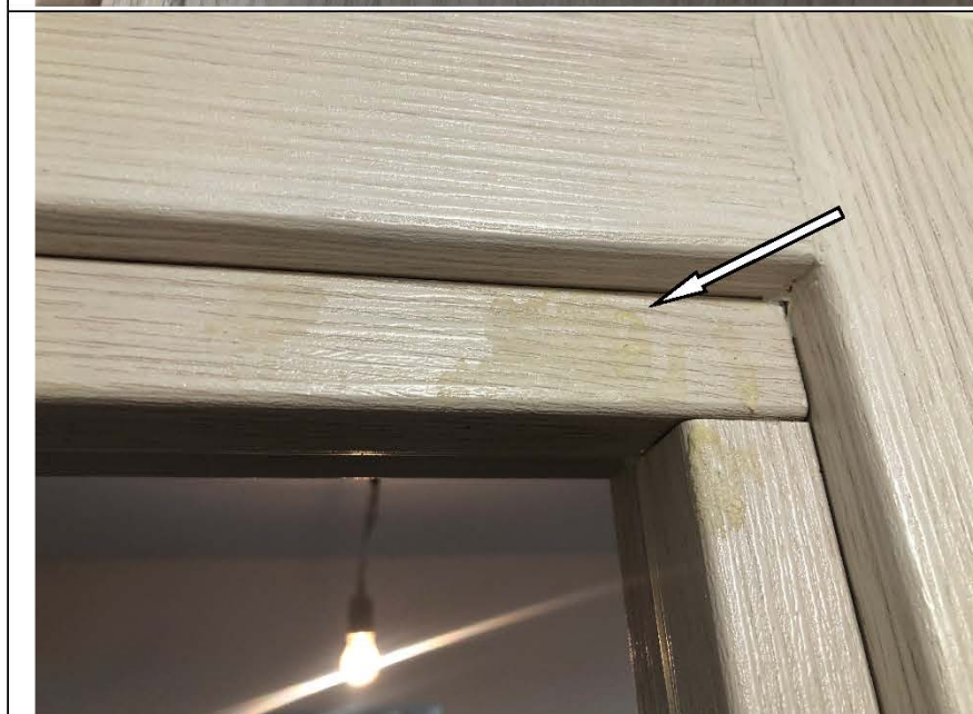
Фото №14. Загрязнение коробки дверного блока в кладовке в квартире.
