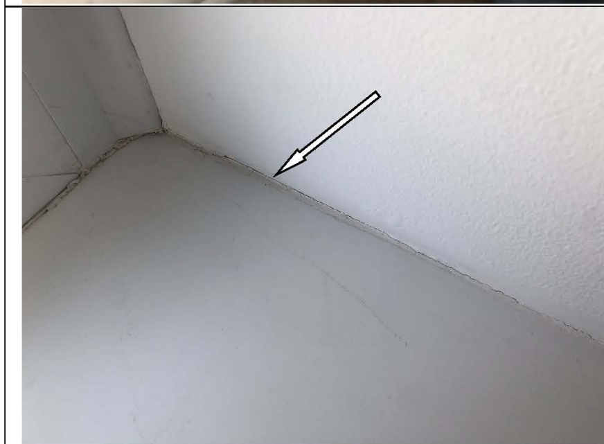
Фото №39. Щель между окрашенным откосом и подоконной доской в кухне.
