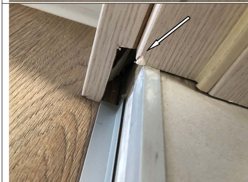
Фото №59. Не доходит наличник дверного блока до напольного покрытия в ванной комнате.
