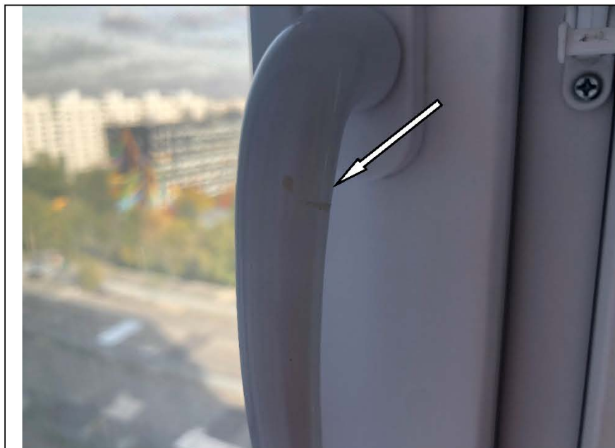
Фото №46. Загрязнение на ручке оконного блока ПВХ в гостиной.
