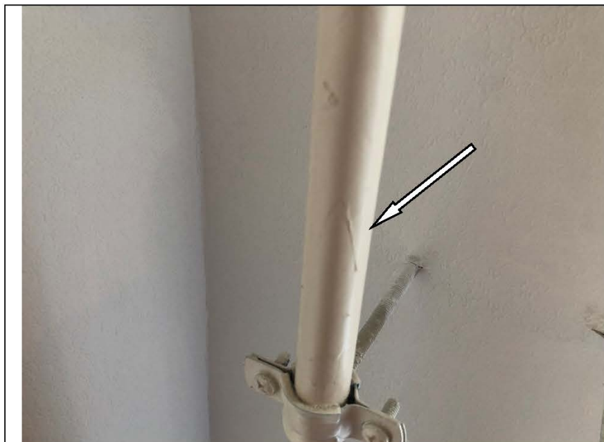
Фото №37. Неровности, полосы при окрашивании труб отопления в спальне.
