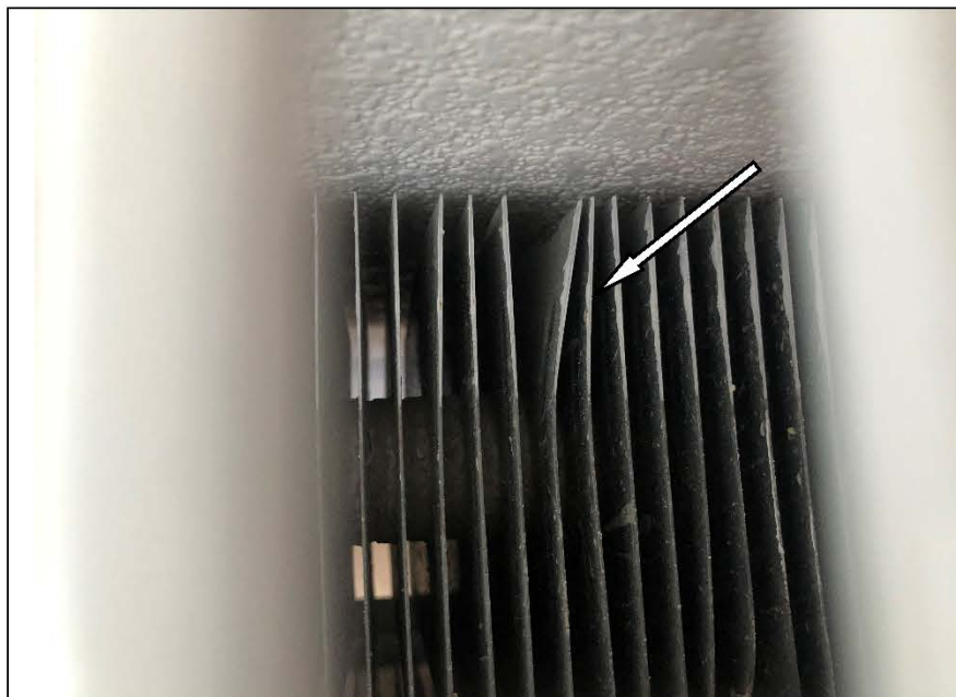
Фото №34. Загрязнение и замятие на радиаторе в спальне в квартире.
