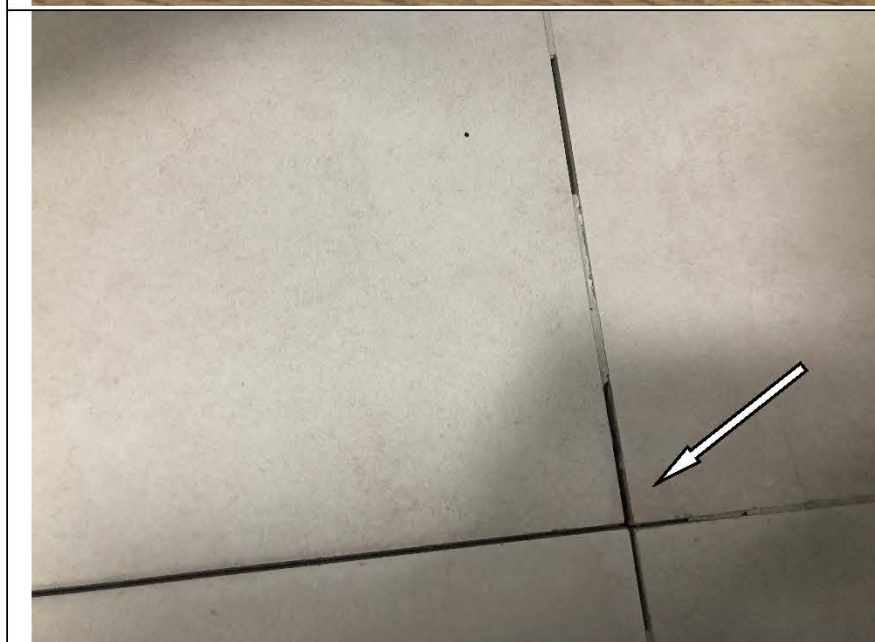
Фото №62. Глухой звук на напольной керамической плитке в ванной комнате.
