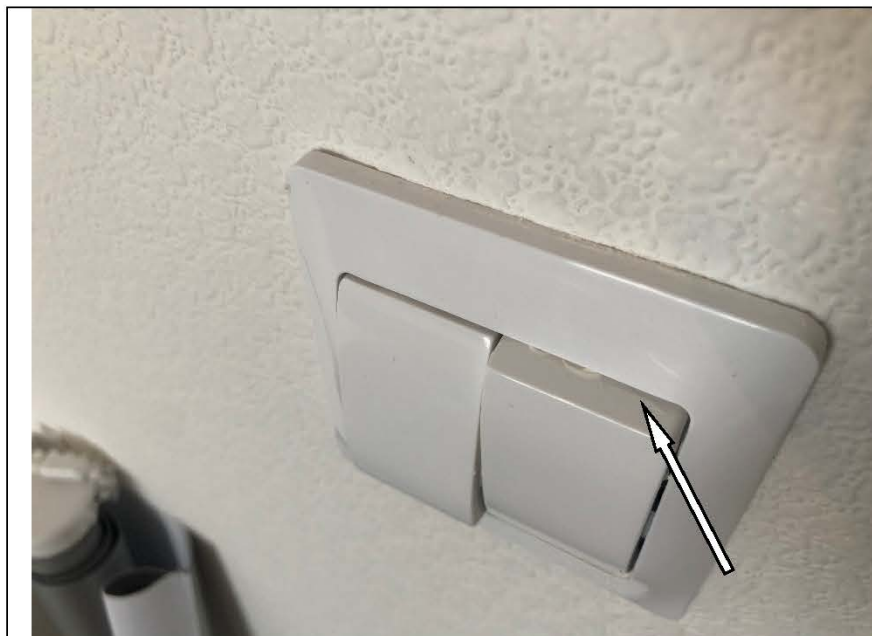
Фото №22. Загрязнен выключатель в спальне в квартире.
