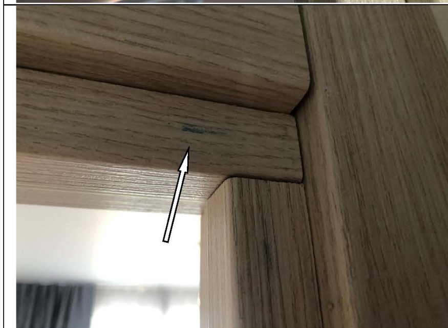
Фото №15. Загрязнение коробки дверного блока в спальне в квартире.
