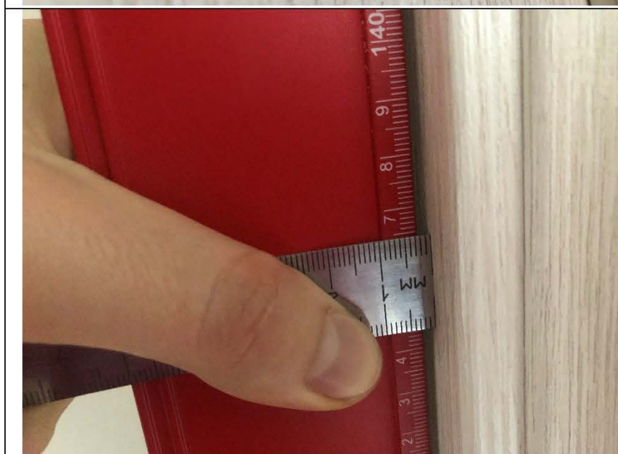
Фото №65. Отклонение наличника в гостиной в квартире.
