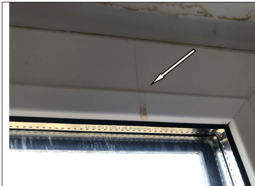
Фото №55. Загрязнения, царапины на профиле оконного блока ПВХ в спальне.
