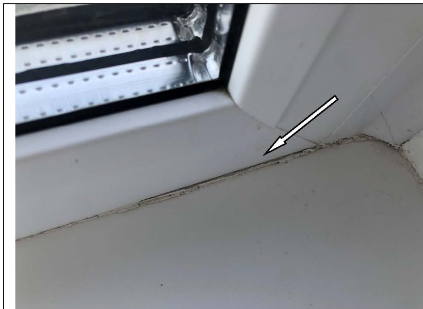
Фото №43. Щель между оконным блоком ПВХ и подоконной доской в кухне.
