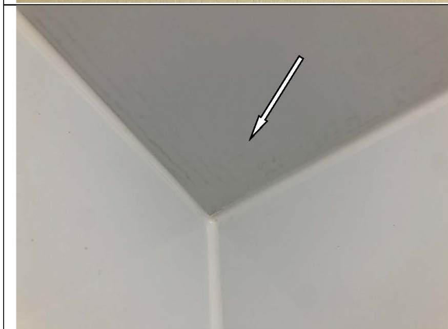
Фото №27. Загрязнение на полотне окрашенном потолка в санузле в квартире.
