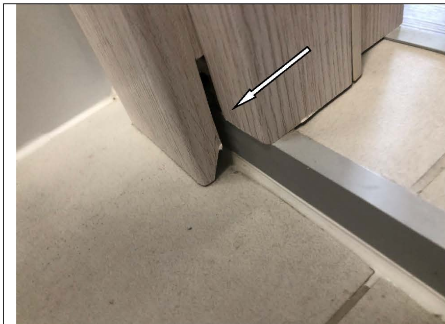
Фото №58. Не доходит наличник дверного блока до напольного покрытия в санузле.
