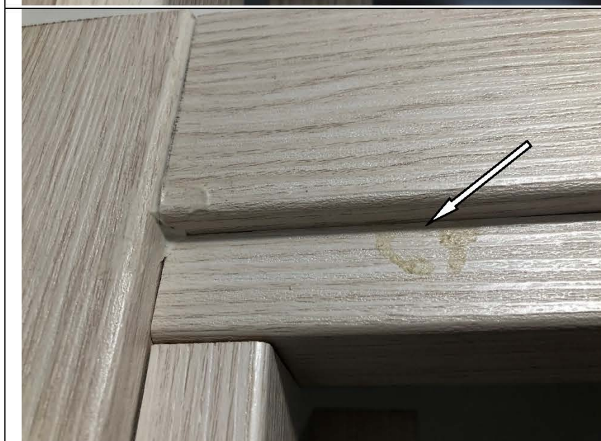
Фото №17. Загрязнение коробки дверного блока монтажной пеной в ванной комнате в квартире.
