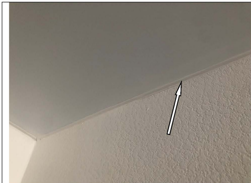
Фото №28. Загрязнение на полотне натяжного потолка в гостиной в квартире.
