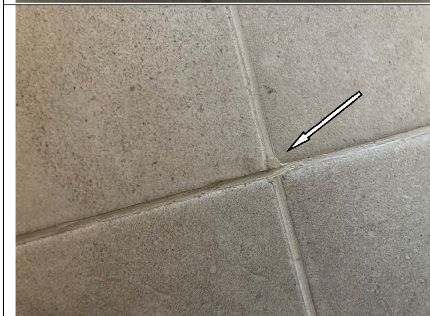
Фото №53. Неровный шов напольной керамической плитки в коридоре.
