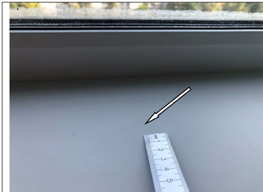
Фото №49. Царапина на подоконной доске в кухне в квартире.
