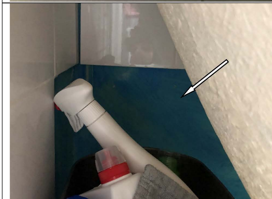
Фото №63. Частично отсутствует настенная керамическая плитка в ванной комнате.
