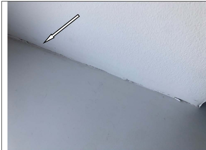
Фото №40. Щель между окрашенным откосом и подоконной доской в гостиной.
