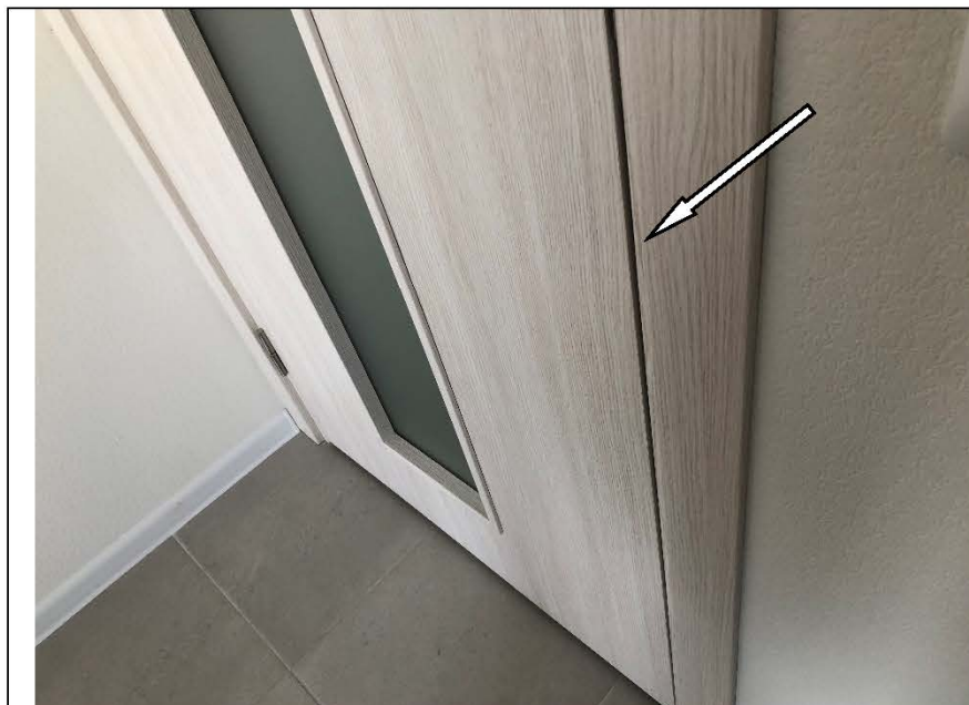
Фото №19. Не открывается и закрывается свободно дверь в кухне в квартире.
