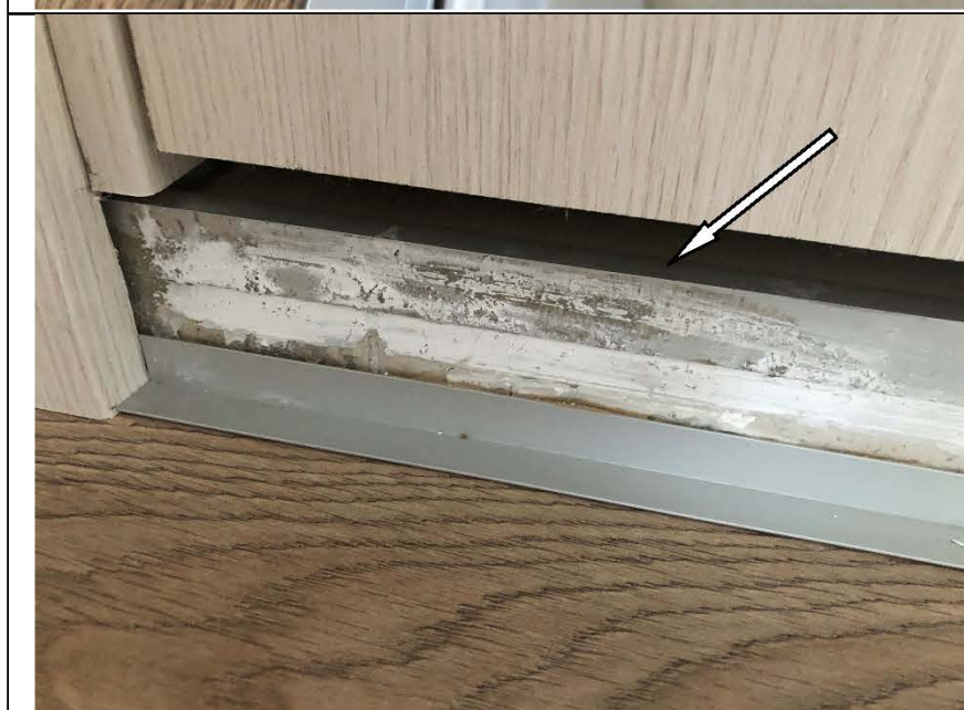
Фото №60. Загрязнен металлический порожек в санузле.
