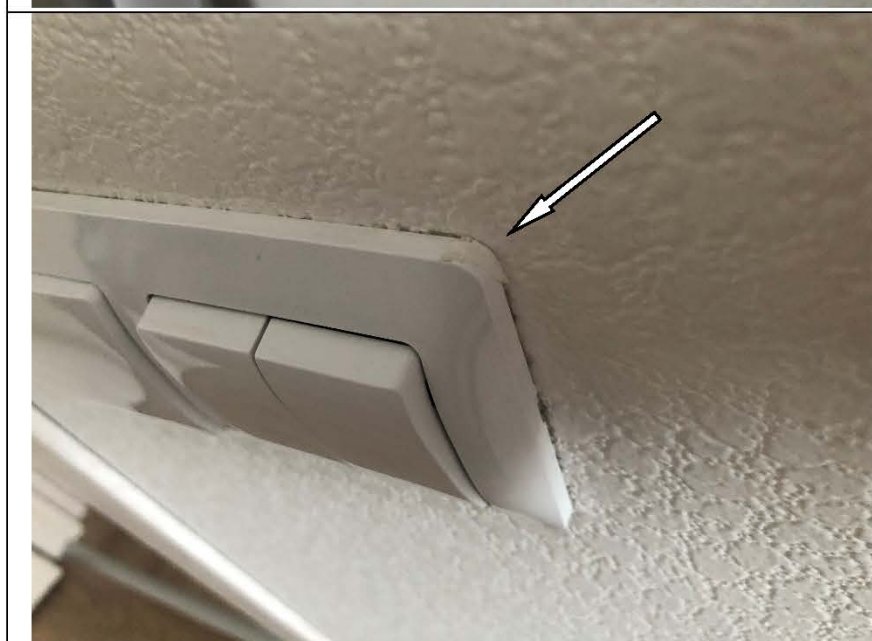
Фото №23. Загрязнен выключатель в гостиной в квартире.
