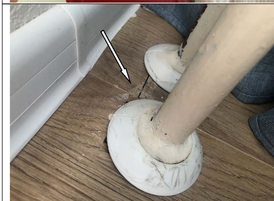
Фото №66. Дефект монтажа отопительных труб в напольное покрытие из ламината в гостиной.
