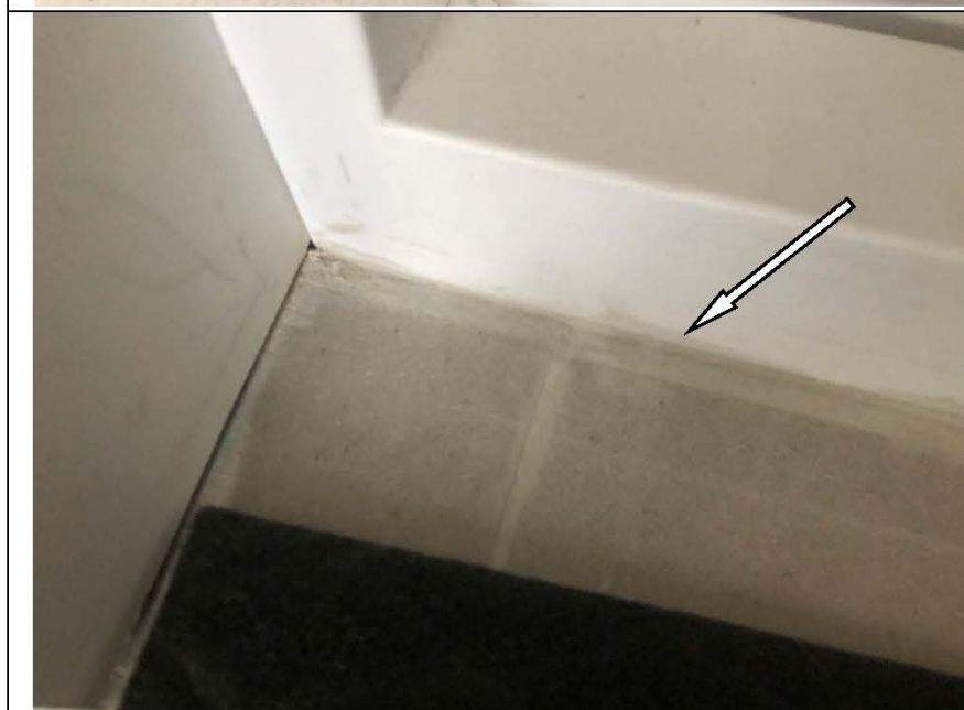
Фото №32. Загрязнение напольной керамической плитки в коридоре.
