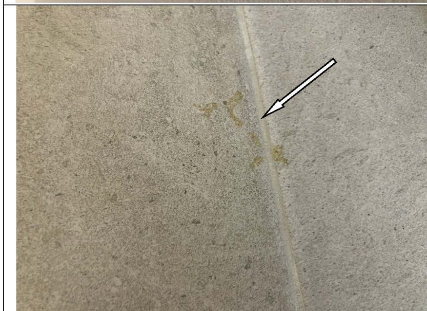
Фото №29. Загрязнение напольной керамической плитки в кухне.
