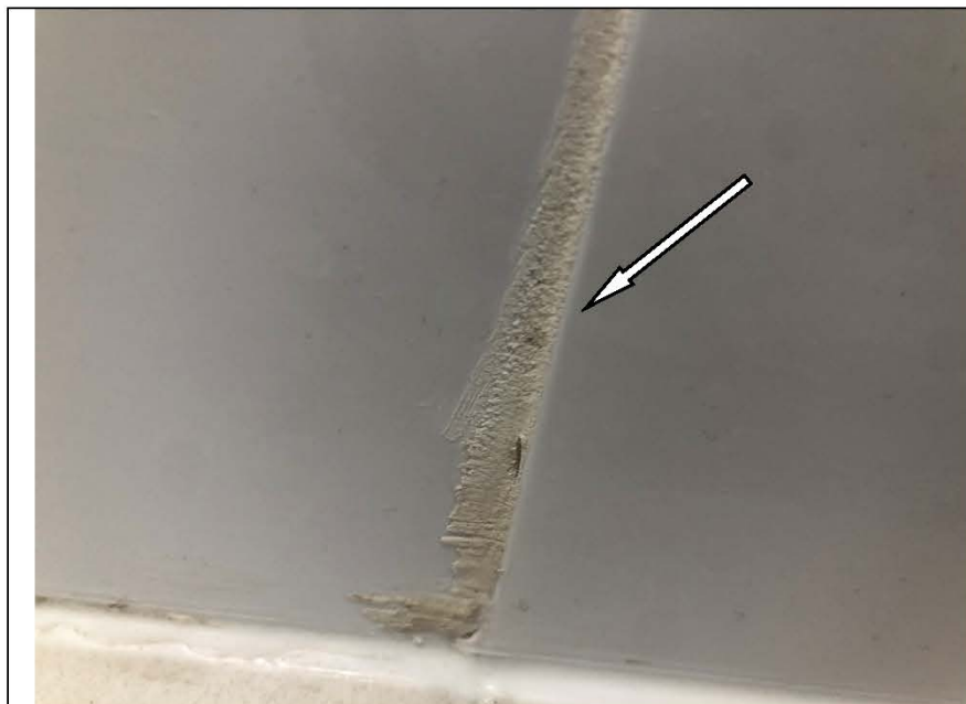
Фото №31. Загрязнение настенной керамической плитки в санузле.
