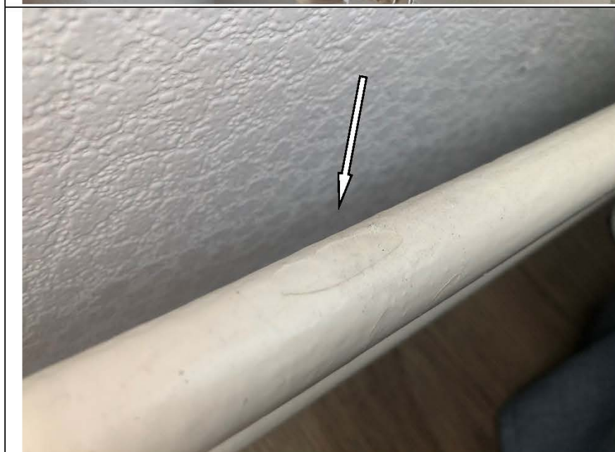
Фото №38. Неровности, полосы при окрашивании труб отопления в гостиной.
