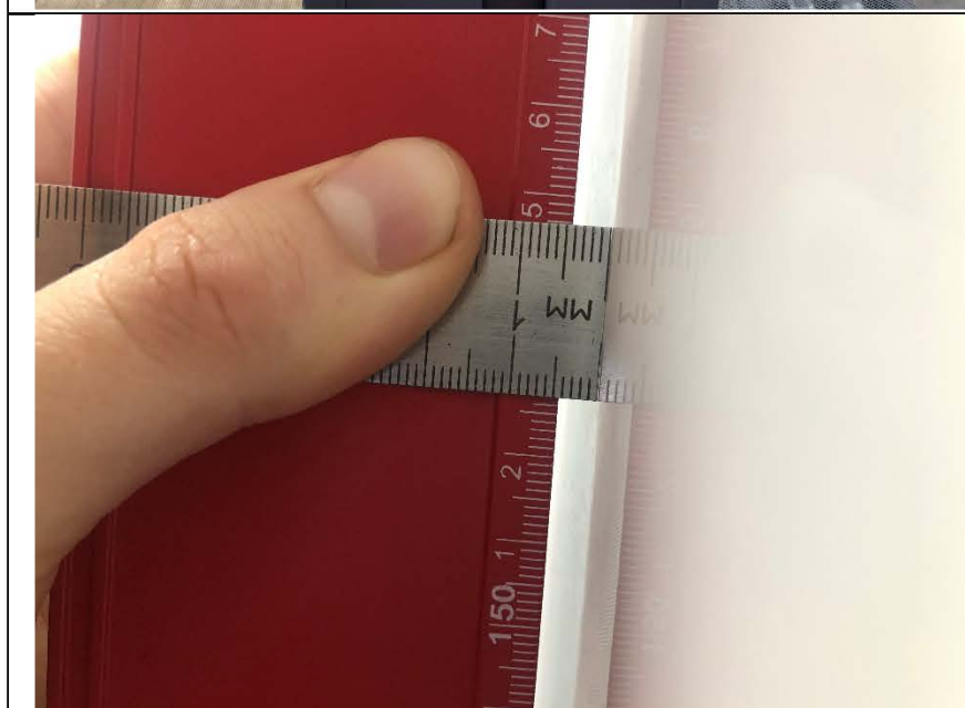
Фото №57. Отклонение стен в санузле в квартире.
