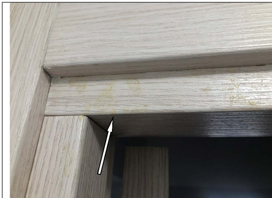
Фото №16. Загрязнение коробки дверного блока монтажной пеной в санузле в квартире.
