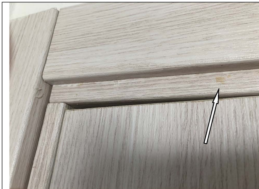
Фото №13. Загрязнение коробки дверного блока в кухне в квартире.
