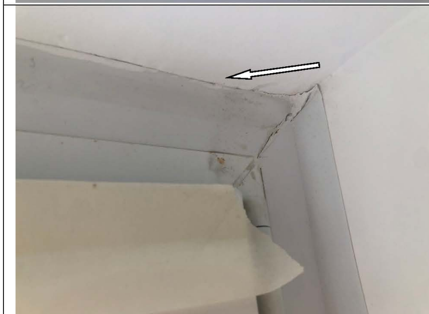
Фото №44. Щель между оконным блоком ПВХ и подоконной доской в гостиной.
