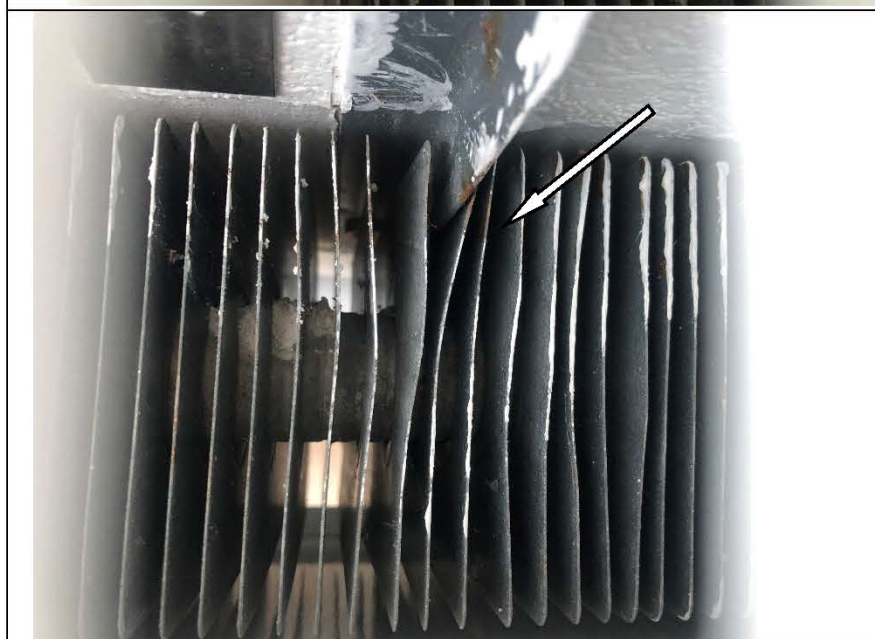
Фото №35. Загрязнение и замятие на радиаторе в гостиной в квартире.
