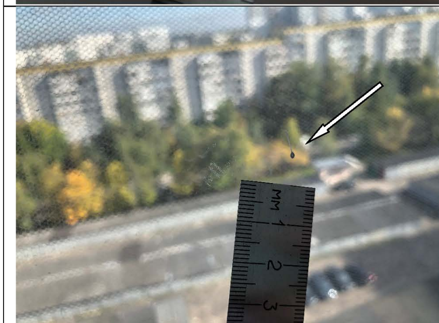
Фото №48. Окарины, царапины на стеклопакете оконного блока ПВХ в спальне.
